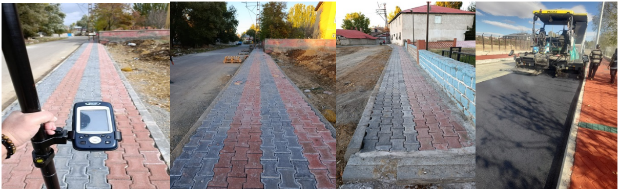
İlimiz Merkez İlçesi Muhtelif Mahallerinde Cadde ve Sokaklarda Renkli Desenli Asfalt Kaldırım Yapımı ve Kilitli Parke Taşı Yapımı İşi
